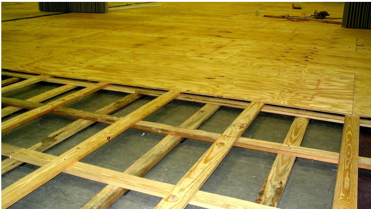
Слика 49. Дрвени летви – подна конструктивна изведба
