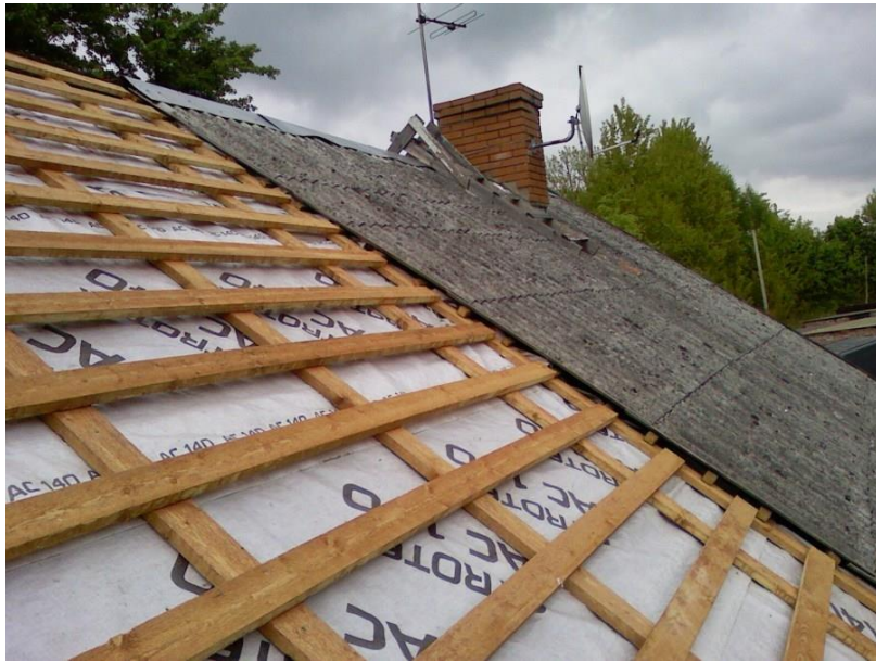
Слика 48. Дрвени летви на покривна конструкција
